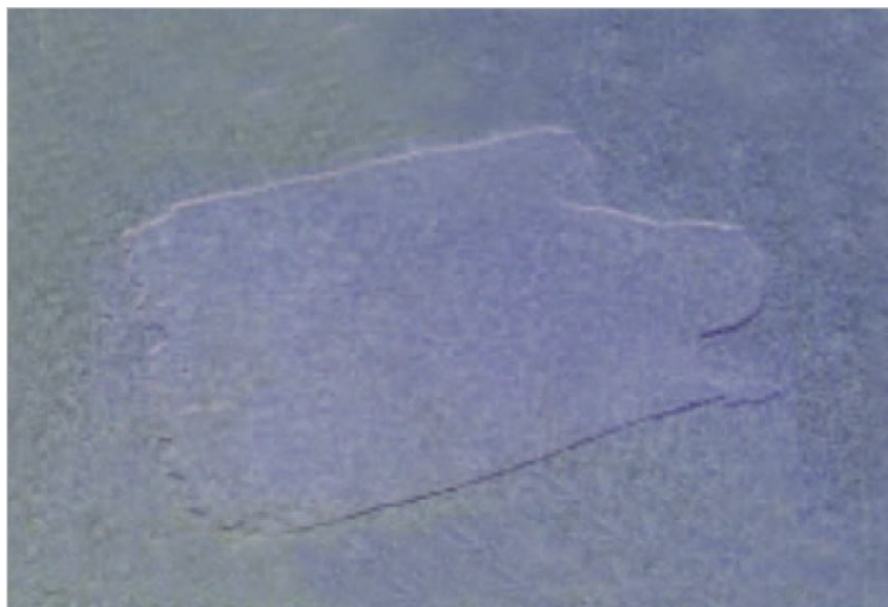
Рис. 2.44 Многократная окраска/отслаивание верхнего слоя
