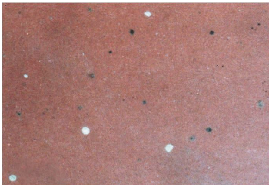
Рис. 2.73 Пятна от копоти и серной кислоты
