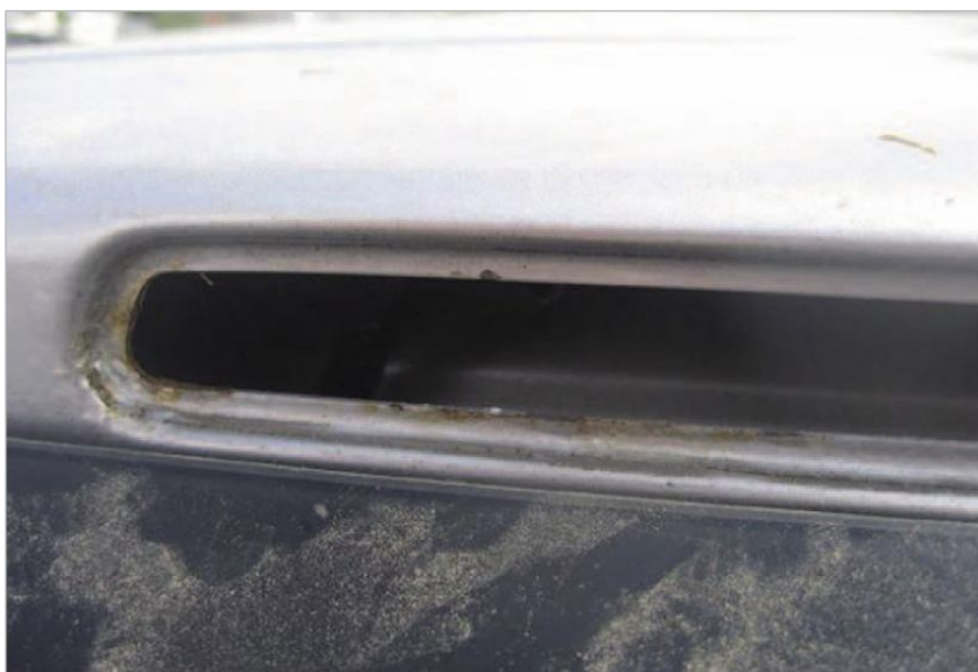
Рис. 2.19 Коррозия кромки проёма
