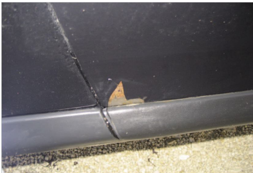
Рис. 2.12 Подплёночная коррозия у нижнего края двери
